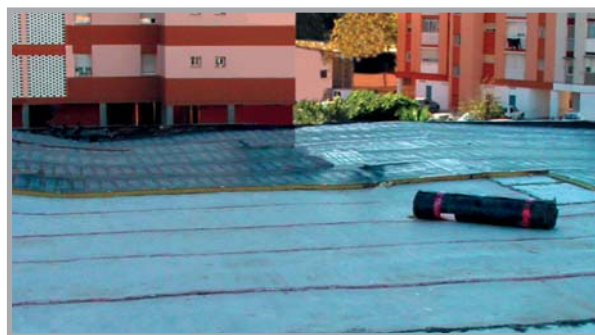
Detalles de la cubierta, Cádiz. No transitable. Impermeabilización, en mal estado, realizada con lámina de aluminio.
