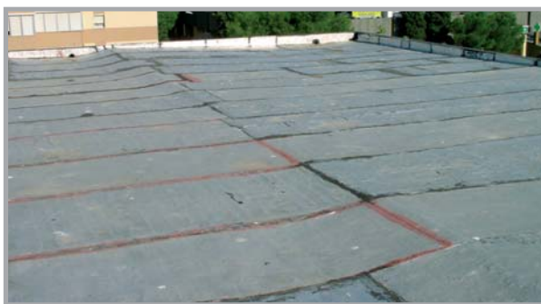
Detalles de la cubierta, Cádiz. No transitable. Impermeabilización, en mal estado, realizada con lámina de aluminio.
