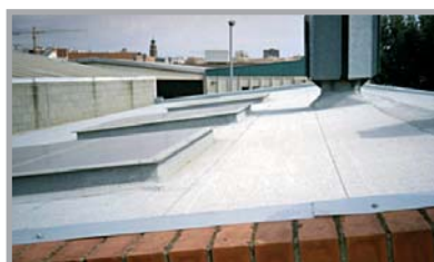
Detalles de ejecución y de acabado de claraboyas o lucernarios.
