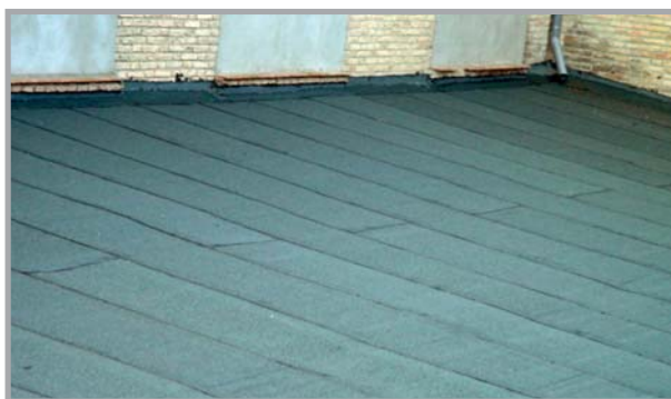
Detalles de cubierta finalizada.
